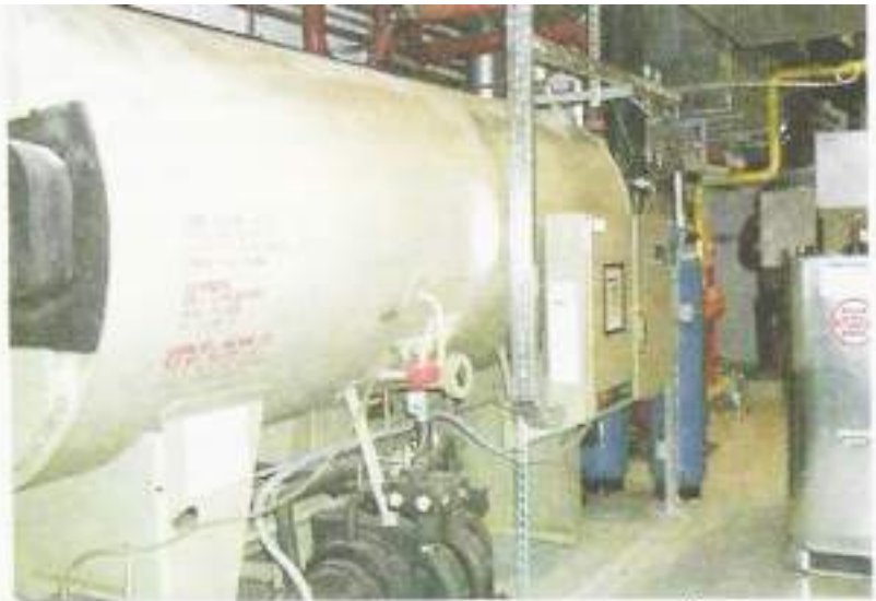
Simple vapour absorption machine.
